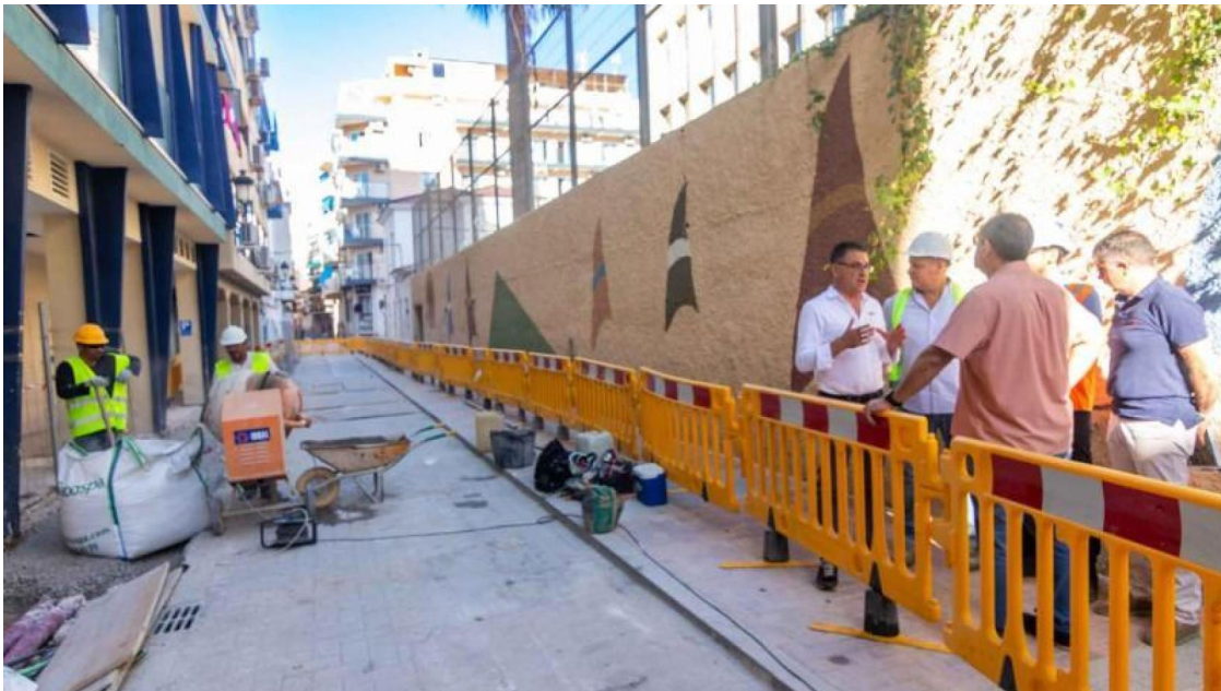
Los trabajos afectarán ahora al tramo que discurre entre las calles Carmela Martínez y Pintor Lozano
