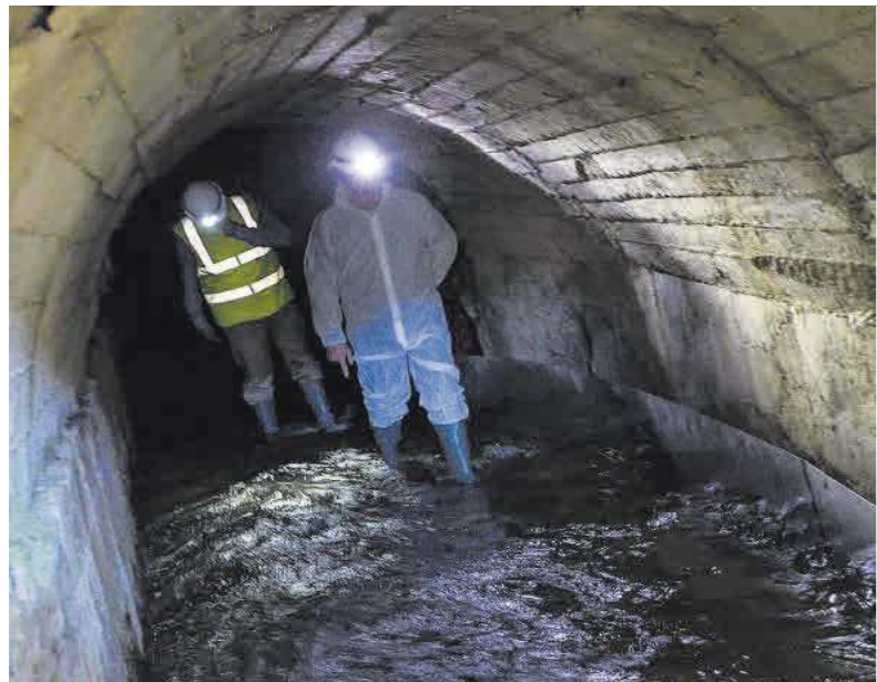
Uno de los túneles por los que discurre el agua del canal del Aramo. | Miki López
