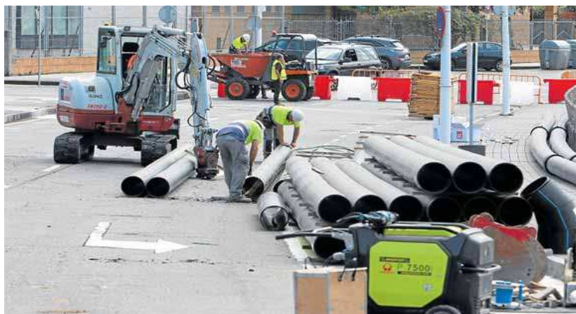
Trabajadores de Dragados, empresa encargada de la renovación del colector, en Doctor Fleming. J. M PARDÓ
